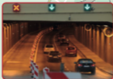
Tunel pod Wisłostradą
