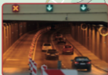
Tunel pod Wisłostradą
